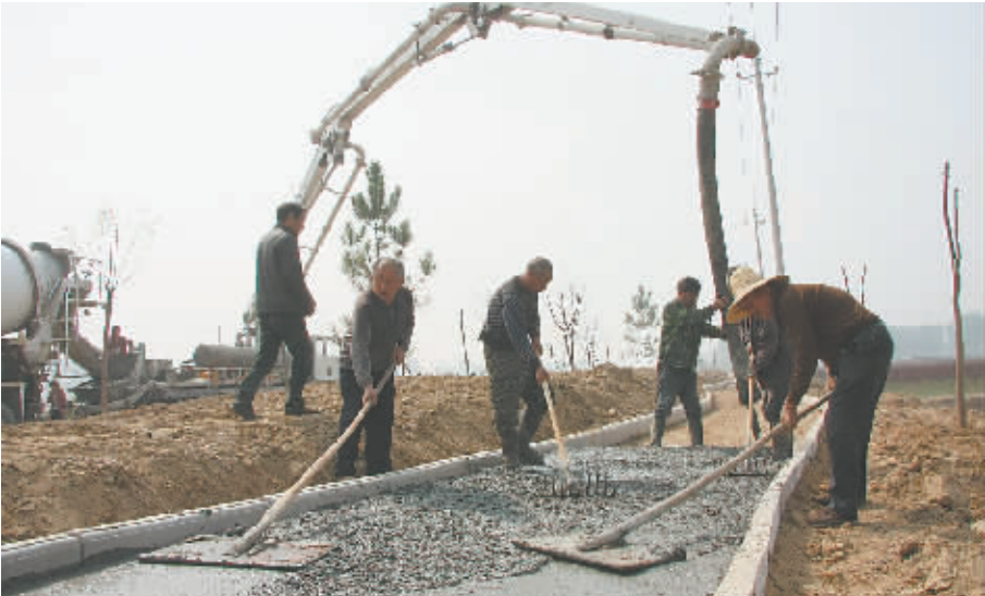
4月16日,武陟县嘉应乡黄河风情大道两侧,工人正在紧张施工,铺设人行道。连日来,该县加大旅游基础设施建设和宣传营销工作力度,为五一迎接游客作好准备。
