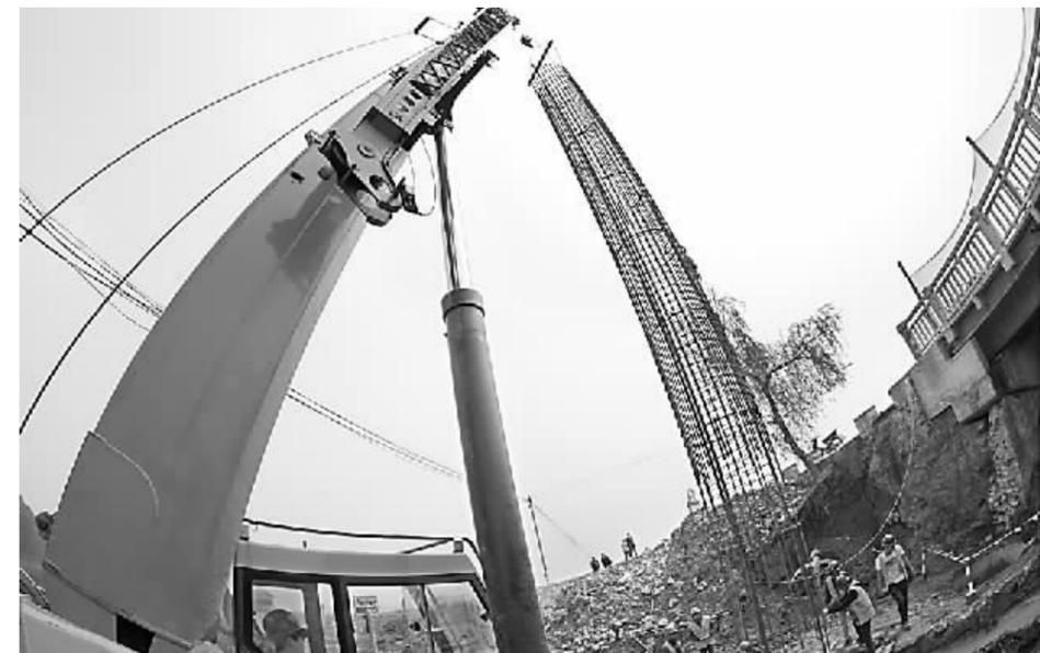
昨日,工人们正在S308沁沁线修武至焦作段改建项目沙河大桥工地进行桥梁桩基钢筋笼吊装作业。S308沁沁线修武至焦作段二改一工程,是省、市重点工程,道路全长27.822公里,总投资3.58亿元。该工程开工
