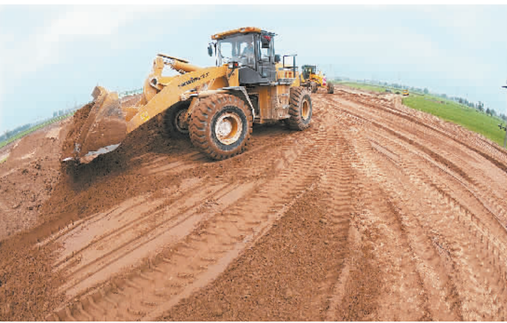
昨日，装载机 and 摊铺机在武云高速公路施工现场平整路面。武陟至云台山高速公路为郑州桃花峪黄河大桥的向北延伸线，全长 36.93 公里，总投资 9.74 亿元，自去年 7 月份开工建设以来，已累计完成投资 98467 万元，完成路基 11 公里，桥涵基础工程正在加紧建设。
