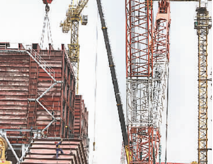
昨日，神华国能焦作电厂有限公司2×660MW机组项目工程的建设者在进行电袋除尘器的吊装作业。该项目是在关停焦作电厂6台220MW机组的情况下，异地建设2台660MW超超临界凝汽式燃煤发电机组，并同步建设烟气脱硫、脱硝装置。该项目建成投产后，除尘器出口的烟尘浓度将达到国家排放标准的特别排放值要求。
