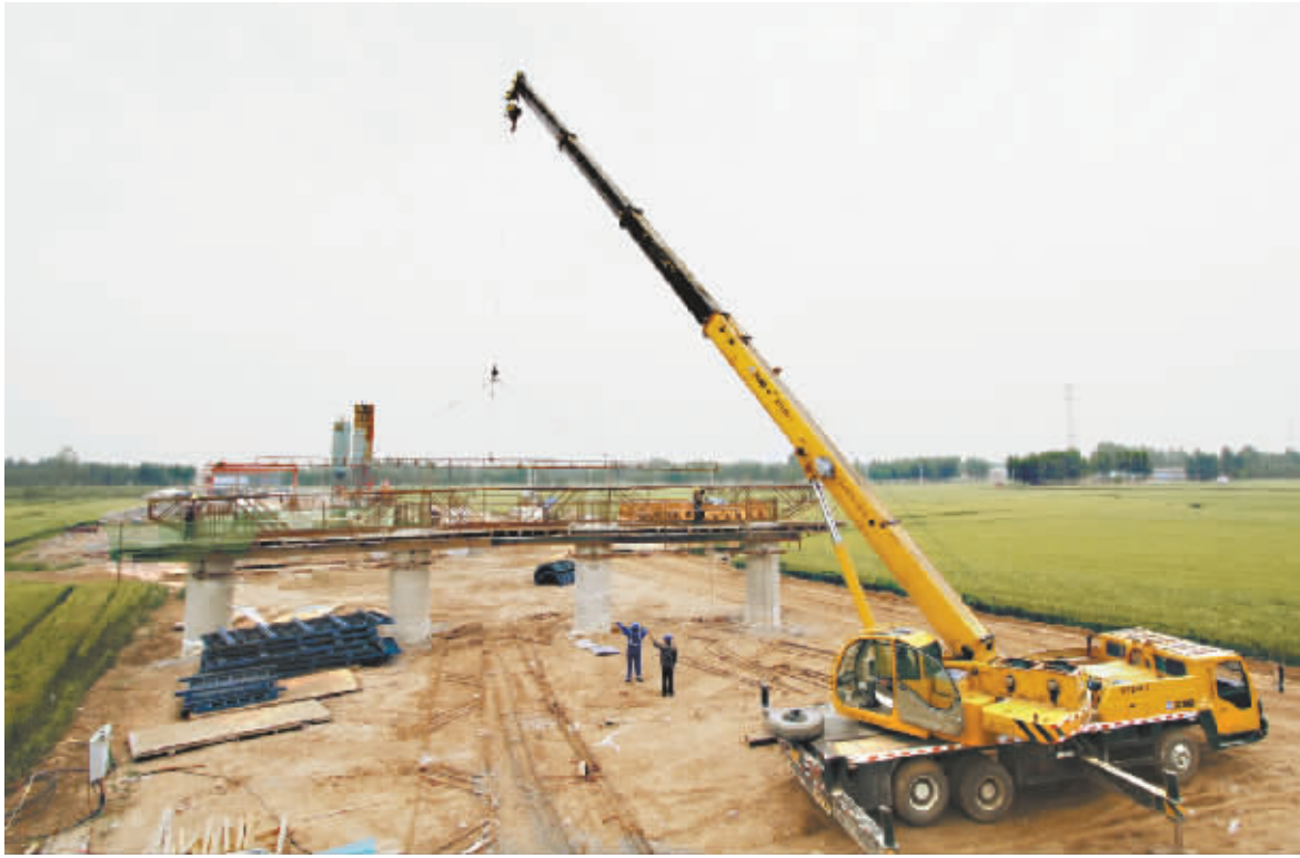
S104郑常线马营至小中里段一级公路改建项目施工现场。毛保党 摄
