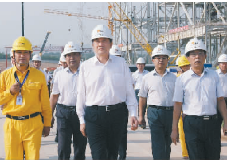
市委书记孙立坤等领导在华润电力焦作龙源电厂2×660兆瓦超超临界火电机组工程现场检查安全生产情况。
