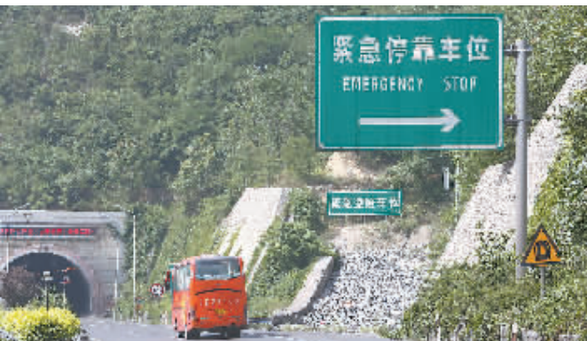
↑紧急停靠车位投入使用10年,已有400多台货车制动失灵后在此安全避险停靠,消除了事故隐患。
