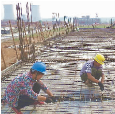
6月16日,河南三木表层材料工业园有限公司项目建设工地,工人正在加紧施工。该项目总投资30亿元,占地1100余亩,一期投资10.26亿元,主要生产醇酸树脂、聚酯树脂等系列产品。该项目自去年7月份开工以来进展顺利,预计8月底建成并开始生产。 许来伟 摄
