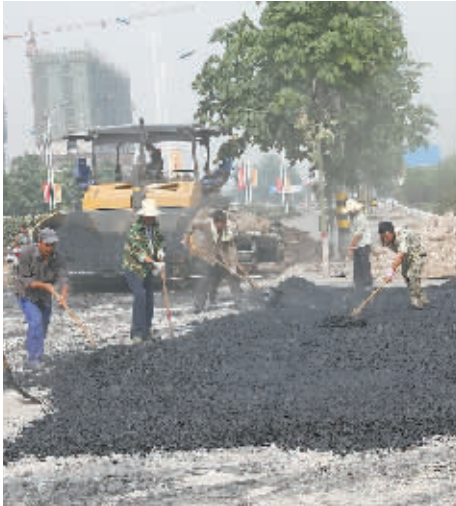
6月15日,博爱公园二期工地机器轰鸣,人头攒动,大型油面摊铺机正在紧张施工。据悉,博爱公园二期工程建设占地250亩,主要建设内容有湖面、水池、喷泉等公园水系统工程,环园道路及跨湖桥、车行桥、人行桥、穿湖堤等路桥工程,计划投资4430万元。截至目前,该项目已完成整个主体工程量的80%。 刘瑞瑞 摄
