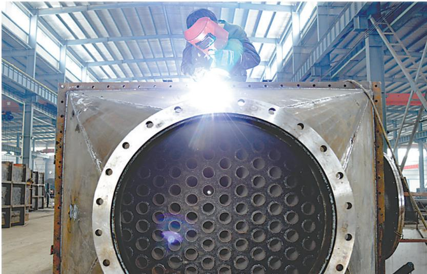
昨日,在焦作力合机械制造有限公司生产车间内,工人正在焊接设备外壳。据介绍,该公司以设计、生产各类换热设备和预热回收装置为主,其主要产品之一的热管及翅片管式余热回收装置是电力、钢铁、建材等高能耗能企业节能减排的关键设备,投产以来产品一直供不应求,今年前6个月已经实现销售收入8000万元。本报记者 翟鹏程 摄
