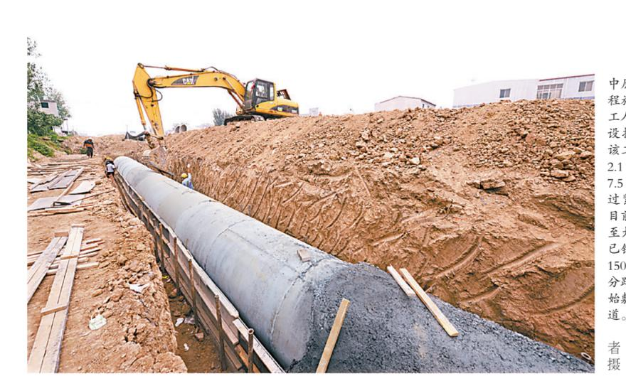
昨日,市中原路改造工程施工现场施工人员正在敷设排水管道。该工程总投资2.1亿元,长7.5公里。经过紧张施工,目前,丰收路至大沙河桥段已铺设排水管道1500米,部分路段已经开始敷设排水管道。
