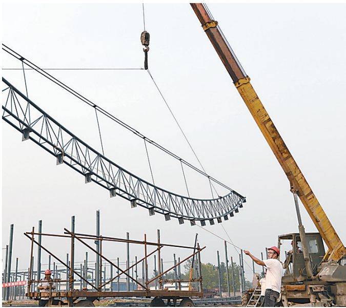
7月29日，沁阳市年产10万吨新型节能高档铝型材和高档节能门窗项目工地，工人们正在吊卸厂房建设钢结构件。该项目由河南省天鹄型材有限公司投资12亿元兴建，采用国际先进的铝型材隔热断桥节能技术，项目建成投产后，年可新增产值20亿元，新增就业1000余人，实现利税3.4亿元。
