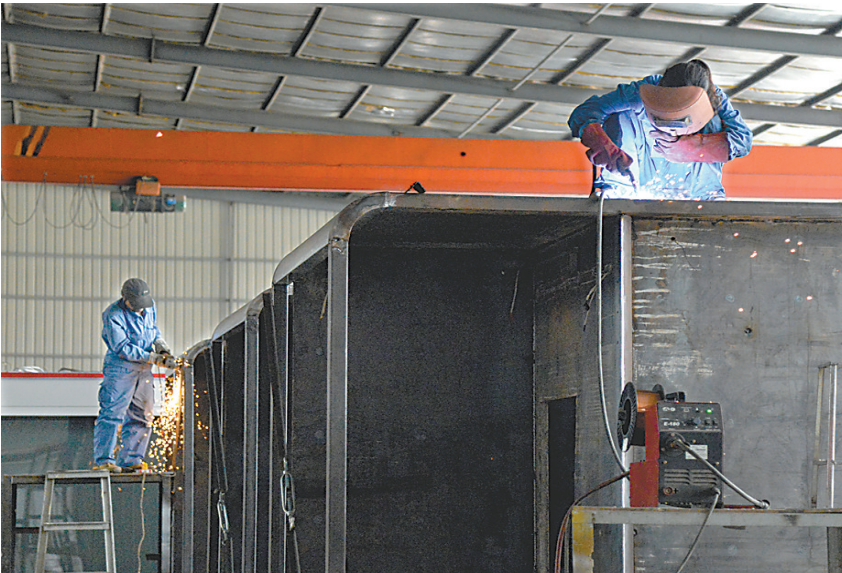
昨日，在九龙聚海工贸公司生产车间里，工人正在制作便民服务站。该公司凭借自身的技术力量承担了我市“十大建设”数字化便民服务站的设计制作，启动以来社会反响良好。如今，该公司正在组织力量加快生产速度，推进网点建设。
