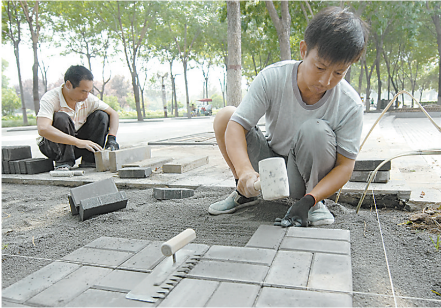
近日，施工人员正在市人民广场铺设吸水土砖。此次人民广场升级改造，在绿地周围安装了竹篱笆，在树池周边铺设了吸水土砖，使广场环境进一步得到改善。
