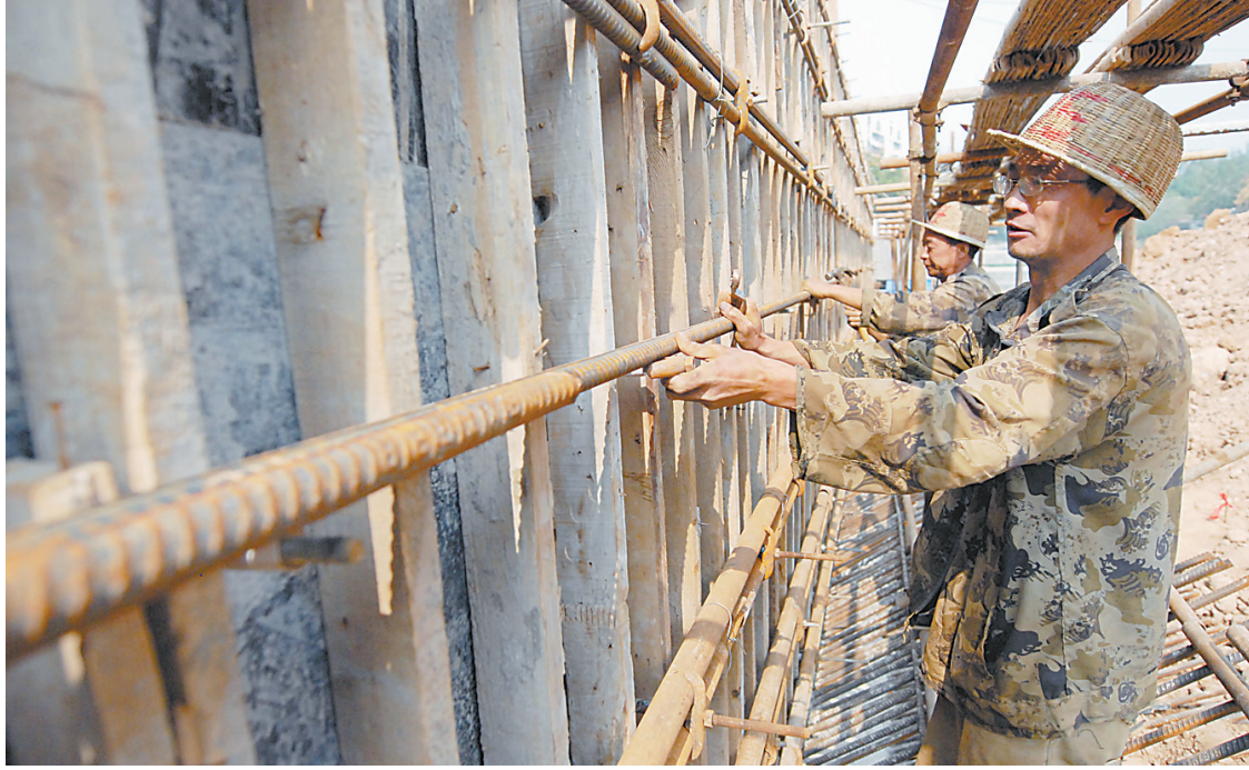
图为学生路群英河桥施工现场。据介绍,该桥于今年6月中旬开工,目前桥的底部承台与东西两侧背墙基础建设已全部完工,预计今年11月底恢复通车。
