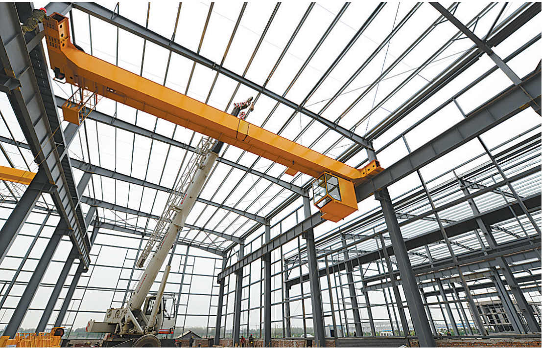
昨日，河南维科重工机械有限公司年产300台（套）智能移动式破碎站及50台（套）建筑材料优化系统项目工地，施工人员正在吊装起重设备。该项目由郑州维科重工机械有限公司独资建设，项目总投资10亿元，预计今年12月底前建成并投入生产。该项目投产后，年可实现产值12.5亿元、利税2.5亿元，提供就业岗位800个。
