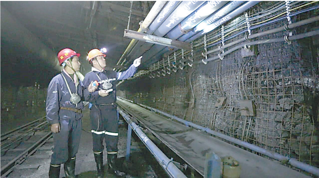
赵固二矿将贯彻落实十八届四中全会精神与矿井安全生产相结合，加强隐患排查治理，加强薄弱环节管控，多措并举拧紧年终“安全阀”。图为 11 月 9 日该矿员工在巡查巷道。
