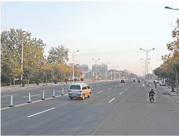
普济路(新月铁路至丰收路段)工程经过施工改造,目前已完工并通车,由原来的双向4车道扩宽至双向6车道,极大地改善了此路段的通行能力。
