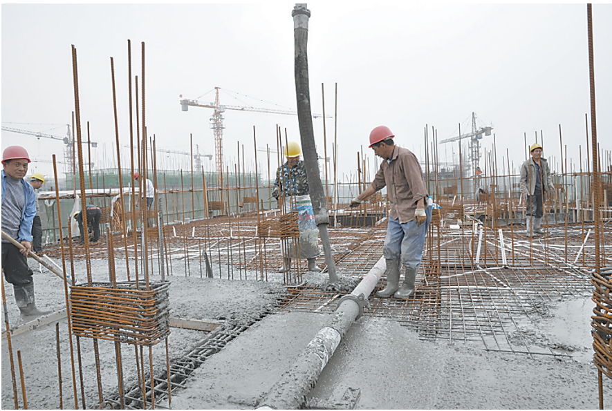
昨日，孟州市新苑小区安置房工程17号楼主体正在紧张施工。该小区是该市高新区重点民生工程，总投资4.5亿元，规划建设20栋11层住宅楼及幼儿园等配套设施。目前，一期工程的5栋楼主体已封顶，小区建成后，可安置5000人居住。 赵春营 摄
