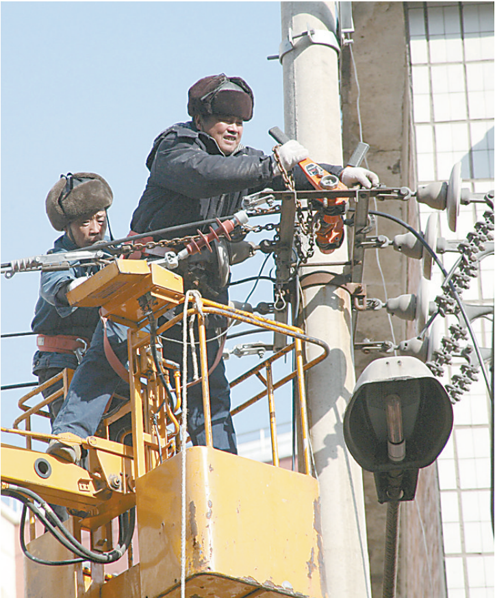
2014年12月30日，温县供电公司组织20余名施工人员对人民路老百货大楼路段990余米低压线路进行升级改造，并新增315千伏安变压器一台，为老城区群众迎峰度冬用电打下坚实的基础。据悉，该公司2014年新增台区14台，升级改造线路5.38千米，有效地消除了3200余户群众用电低电压的问题。 李云霞 摄
