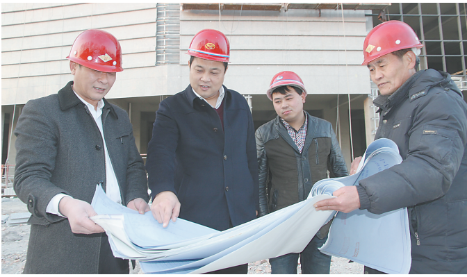
张大为（左二）在清化镇重点项目现场了解工程进展情况。
