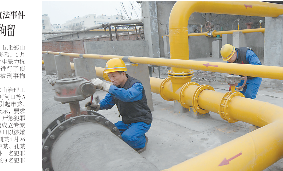
为保障春节期间用气安全，防范各类安全事故发生，近日，焦作中裕燃气有限公司精心部署、周密安排，加强对安全生产环节和安全重点部位的管理，切实做好春节期间我市天然气安全供应保障工作。图为该公司工作人员正在检修供气管道。 本报记者 王正义 摄
