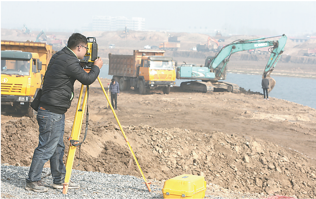
3月27日，建设者在大沙河景观绿化工程施工现场放样。该工程绿化总长度1.75公里，总绿化面积约54万平方米。
