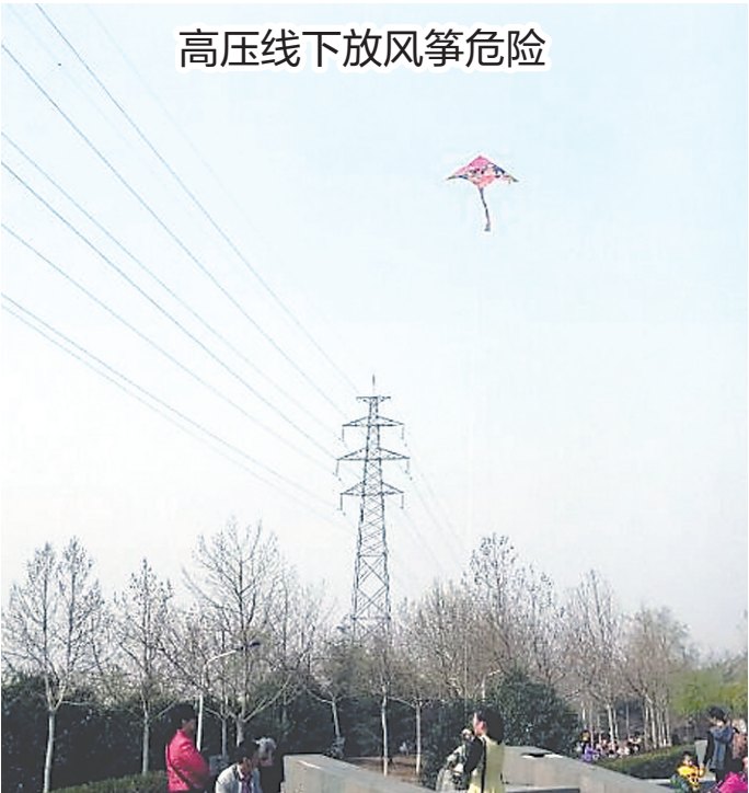
近日,有网友反映,在我市缝山公园和龙源湖公园等地的高压线附近经常有人放风筝,而旁边就是架空高压输、配电线路,风筝一旦挂在高压线上,很容易造成安全隐患。对此,国家电网焦作公司的工作人员表示,《电力设施保护条例》规定,禁止任何单位和个人在架空高压输、配电线路两侧300米区域内放风筝。孙宏光 摄
