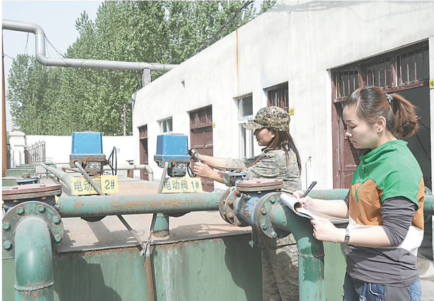
焦煤集团马村矿加大对废弃矿井水的综合利用，投资60余万元建成了一套矿井水净化处理生产线，经过滤、消毒等处理后转化纯净水，供煤炭洗选、煤研砖生产、矿区绿化和喷淋降尘等使用，综合利用率达到86.3%，年节约资金110余万元。因为该节能减排领导小组在检查矿井水沉淀池。
