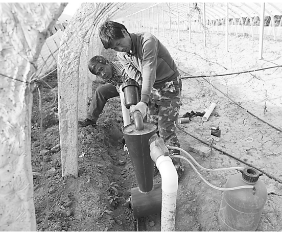
今年年初以来，孟州市强力实施小型农田水利重点县项目，涉及河雍街道、西虢镇、谷旦镇的14个行政村。图为日前施工人员在河雍街道东田村连接输水管道。薛德安 赵春营 摄
