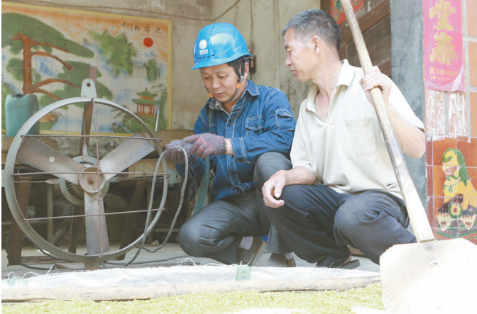
5月25日,温县供电公司农电服务人员上门为岳村乡牛洼村特色食品加工厂提供用电指导。为了满足群众的用电需要,该公司先后为该村新增了315千伏安、200千伏安变压器各一台。 李云霞 摄
