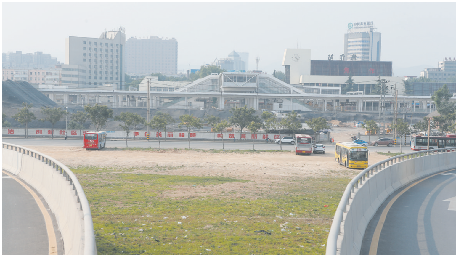
建设中的焦作火车站前广场。
