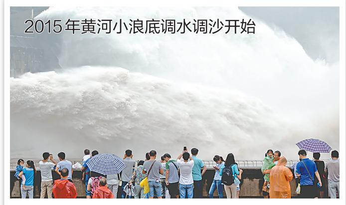
6月29日,2015年黄河小浪底调水调沙正式开始。自2002年以来,黄河小浪底水库每年都要进行调水调沙,将黄河下游 主河槽的过流能力提高,利用"人造洪峰"将下游河床淤积的泥沙送入大海,同时减少小浪底水库的泥沙淤积。图为游客在黄 河小浪底水利枢纽工程出水口观看泄水的壮观场景。 新华社记者 李 安 摄(新华社发)
