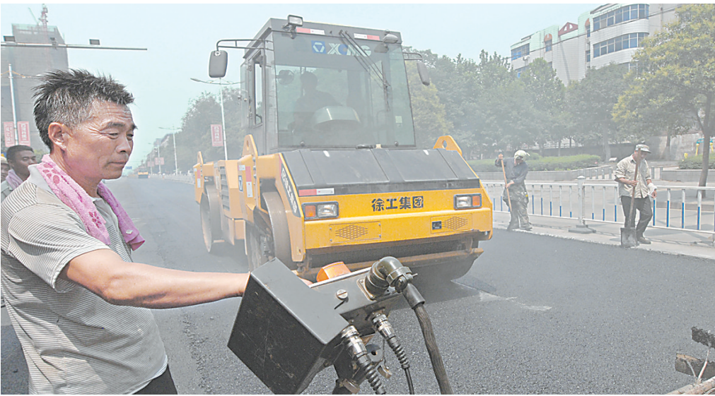
7月13日，施工人员正在工业路（塔南路—轮胎厂铁路桥）快车道铺沥青。据悉，该维修工程全长869.6米，局部路面损毁较为严重，影响过往车辆安全通行。为方便市民出行，施工人员精心组织、科学施工，目前机动车道已提前完工。
