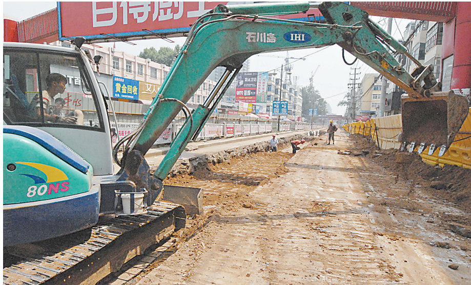
图为老城区集中供热管网工程三标段和平街（建设街—焦东路）施工现场。 本报记者 王正义 摄
