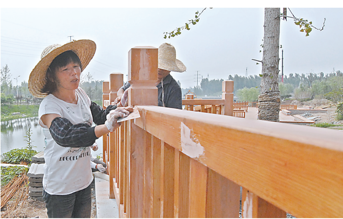
8月3日，酷暑下，工人在贫洞河（丰收路—龙源路）绿化景观工程施工现场忙碌着。据悉，贫洞河（丰收路—龙源路）绿化景观工程全长772米，绿化面积为7万平方米，目前已完成施工量95%，进入收尾阶段。该工程竣工后，将成为市民休闲游览的又一个好去处。图为工人在给护栏抹腻子、刷漆。 本报记者 王正义 摄
