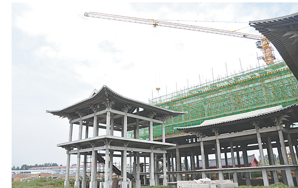
昨日，武陟县妙乐寺塔景区建筑工地上，工人正在紧张施工。据了解，该景区的多宝阁附楼已封顶，主楼已建至二层。 王 岩 李文珊 摄
