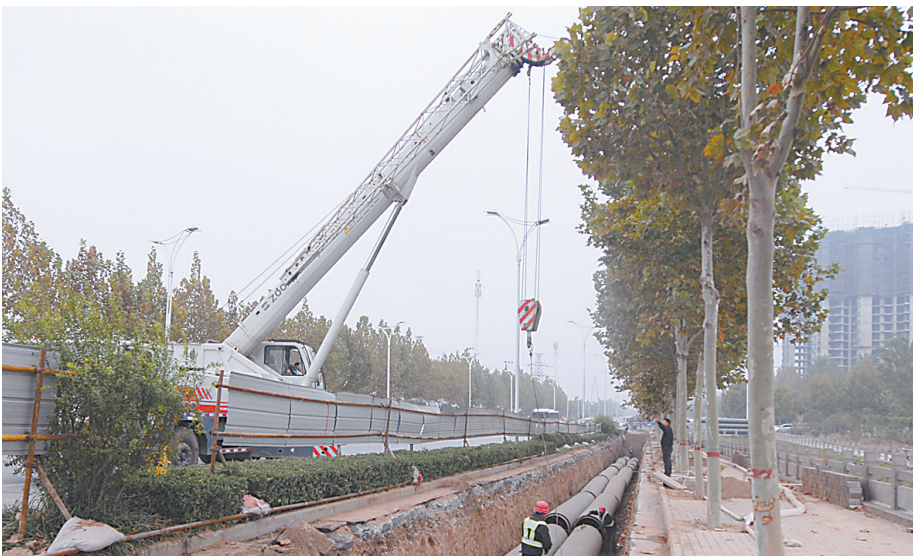
10月19日,万方电厂供热管网工程龙源路(山阳路-民主南路)项目现场正在施工。据悉,该项目全长约3.6公里,计划11月5日竣工。本报记者王正义 摄
