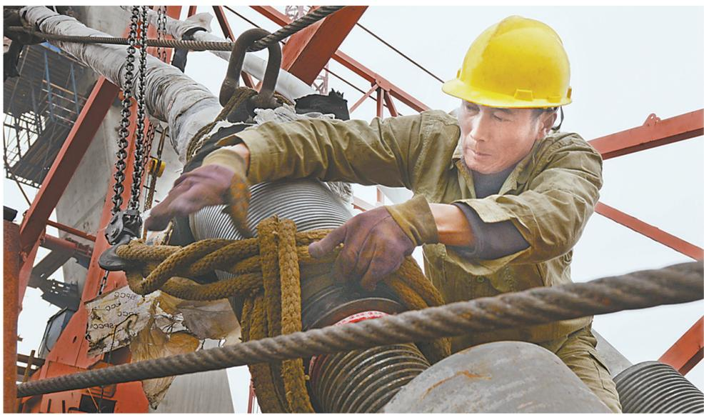
昨日，武云高速南水北调斜拉桥施工现场，施工人员正在高空挂第三号斜拉索。据了解，武云高速南水北调特大桥总投资9500万元，跨径175米，桥梁总长327.48米、宽27米，桥塔高96米，是省内第一座单塔单索面不对称斜拉桥，也是南水北调工程第一座跨越式斜拉桥。承担武云高速四标段施工建设的省公路局集团有限公司项目部周密安排、紧张施工，目前该项目已完成投资5500万元，桥梁配跨工程全部完成，主塔完成工程量的76%，预计该项目于明年6月和龙。
