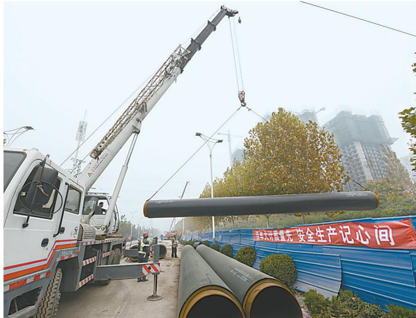
11月9日,市龙源路供热管网施工现场,施工人员正在抓紧敷设管道。为保证城区正常供暖,蒙慧集团今年对全市39条主干道的分支管网和中继泵站开工建设。目前,塔北路、岭南路、普济路、青年路等道路的供热管网已先后完工。对新开工的龙源路、山阳路、建设路等道路的供热管网工程、中继泵站加快建设进度,确保11月15日能够正常运行。 本报记者 刘金元 摄影报道
