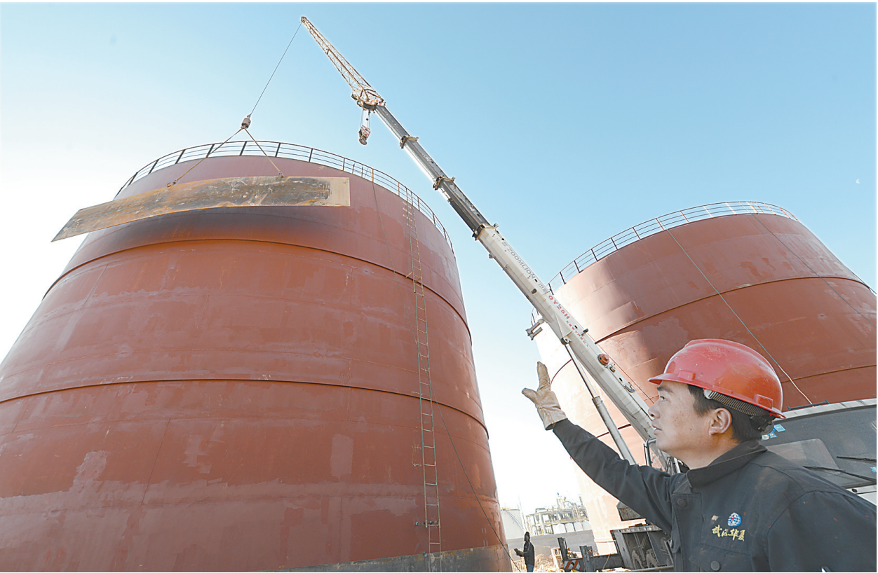
12月4日，沁阳市产业集聚区沁北园区精细化工园项目工地，建设者向在建储存罐吊运钢板。该项目总投资12.7亿元，2015年7月动工建设，目前项目一期已入驻企业6个。
