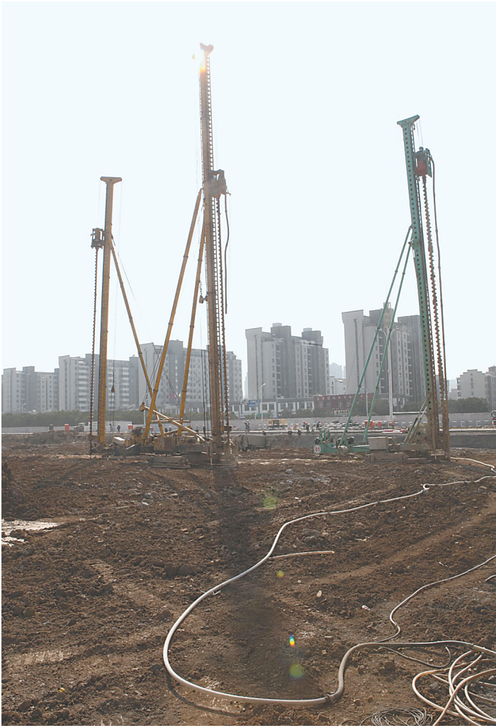
3月6日，总投资35亿元的万达商业广场项目在进行地基桩施工。被列为省、市重点项目的万达商业广场项目开工以来，解放区成立项目服务小分队，深入工地协调解决用电、用水、交通等问题，有力推进了项目建设。
