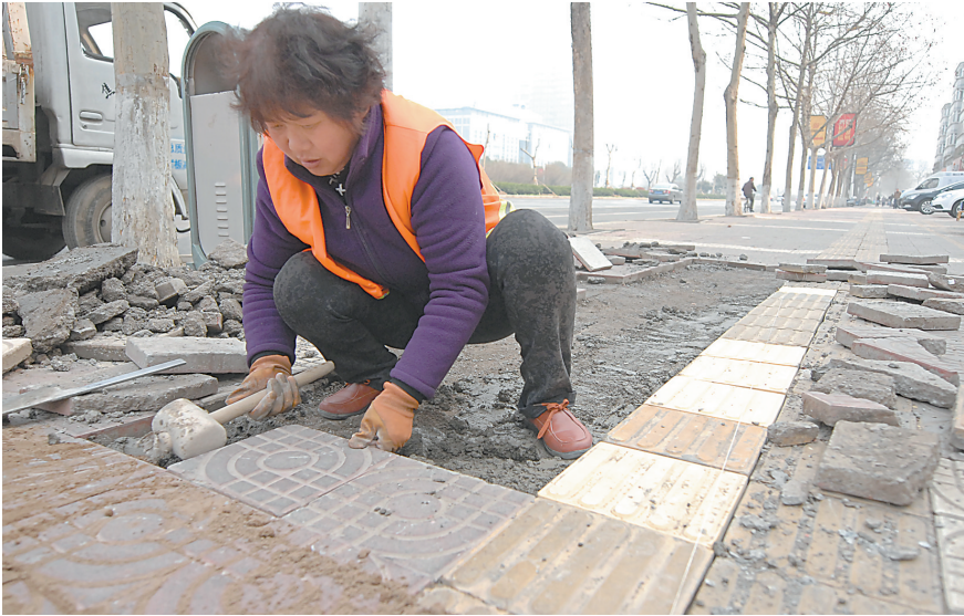
连日来，市住建局结合自身实际，积极开展城区市容秩序整治，组织人员对市人民路、丰收路、迎宾路、解放路等严管路的市政基础设施进行维护。图为工作人员在修补路面。
