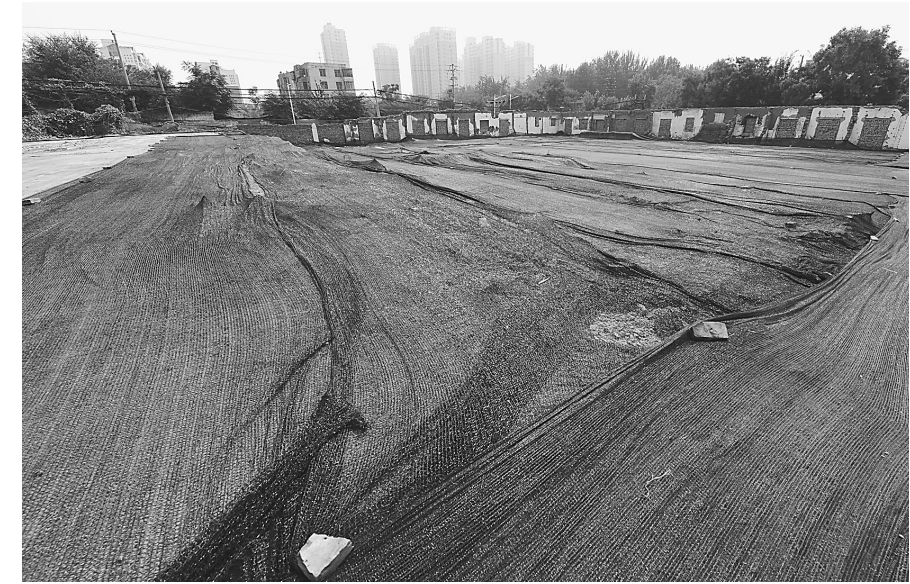
9月18日，焦作咏春塑股有限公司院内原有近1万立方米的垃圾已经全部清运完毕，七百间街道办事处组织工作人员已用遮挡物覆盖地面，防止出现扬尘。
