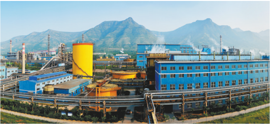
引沁为工业集聚区供水项目。
