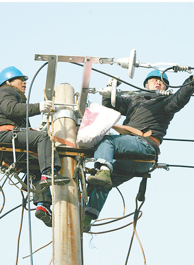
11月28日，温县供电公司组织人员加班加点，对低压线路进行改造，确保有效提升老城区电网供电能力，为迎峰度冬期间群众用上放心电提供保障。李云霞 摄
