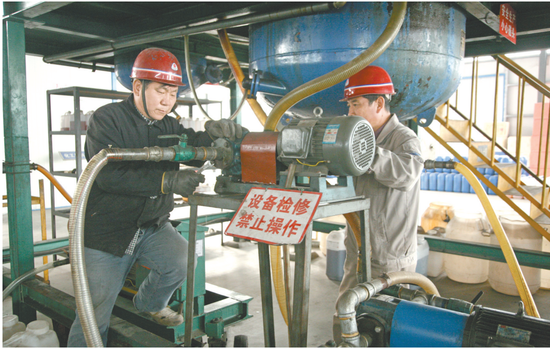
进入四季度以来，方鑫隆公司按照“打好三大战役、决胜第四季度”工作部署，扎实做好安全生产保障工作，为完成全年目标任务奠定基础。图为该公司维修工作队在抢修生产设备。 樊小山 摄
