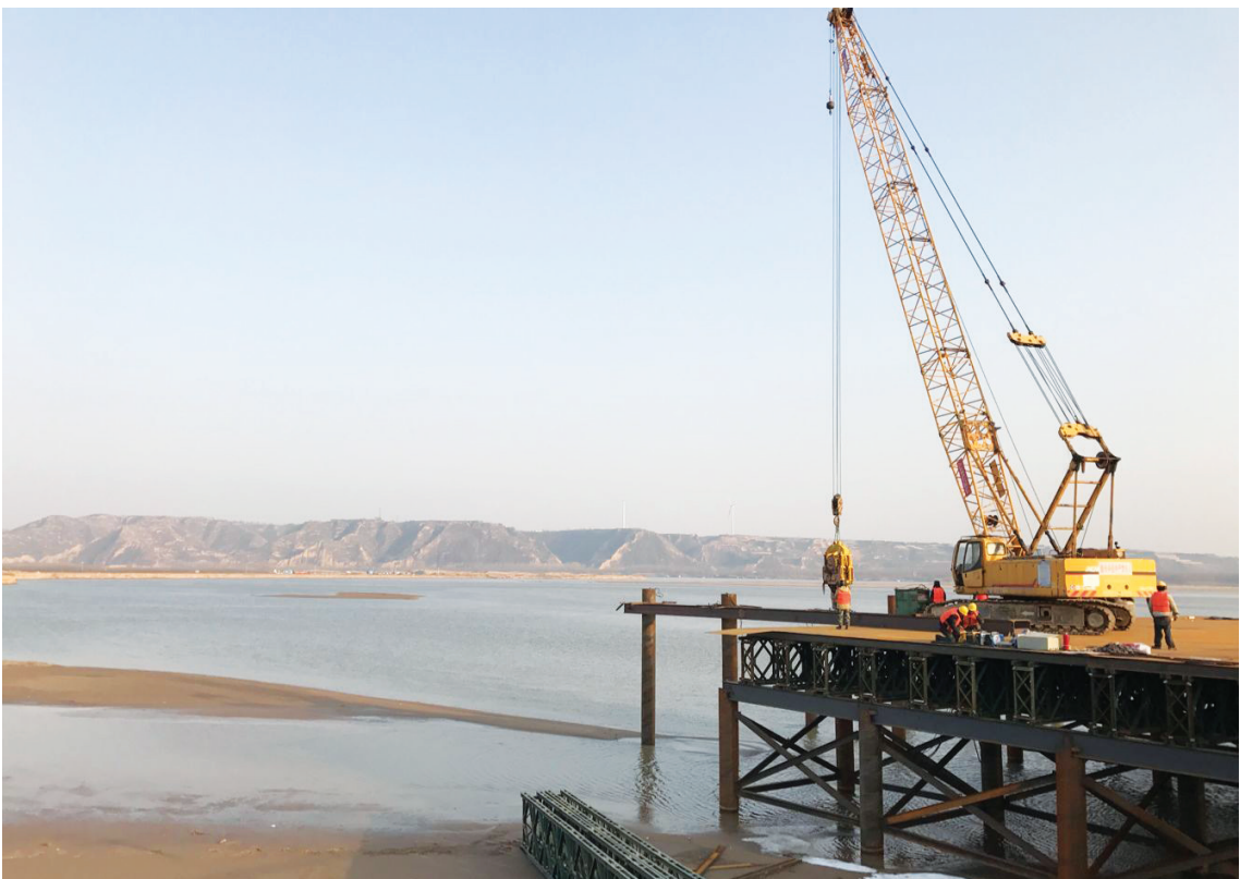
图为正在进行栈桥、桥桩等工程施工的全市十大基础设施项目之一的焦作至荥阳黄河大桥。 马程光 摄
