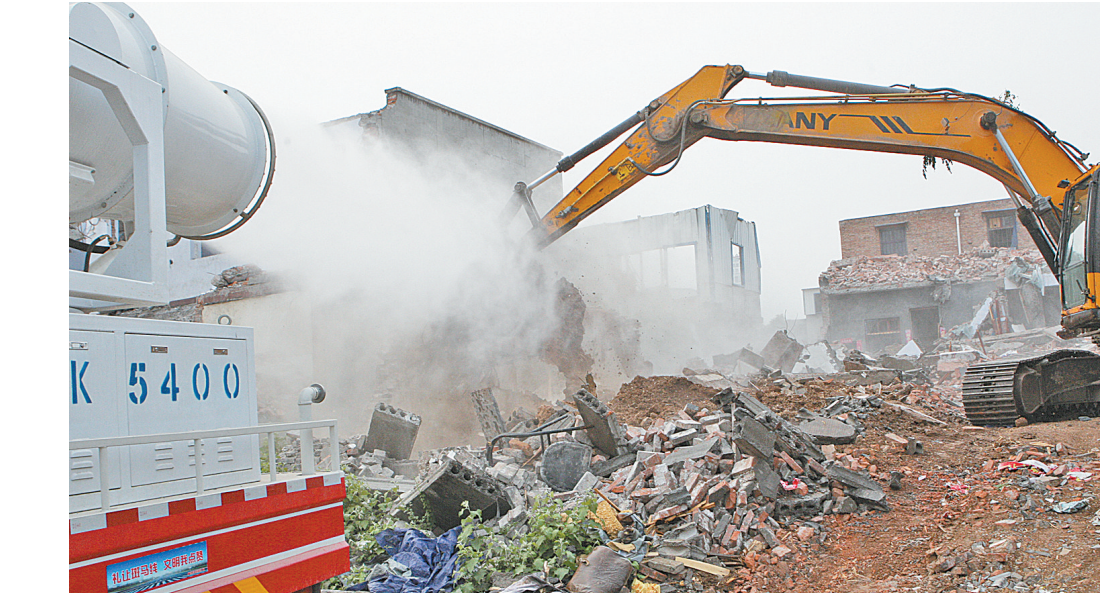
7月1日，解放区王褚街道西于村征迁工作组组织大型机械拆除南水北调绿化带城区段征迁区域内的搬空户房屋。连日来，解放区不断加大征迁工作力度，对已搬空户的房屋在尽量减少扬尘、保证安全环保的基础上进行集中拆除。
