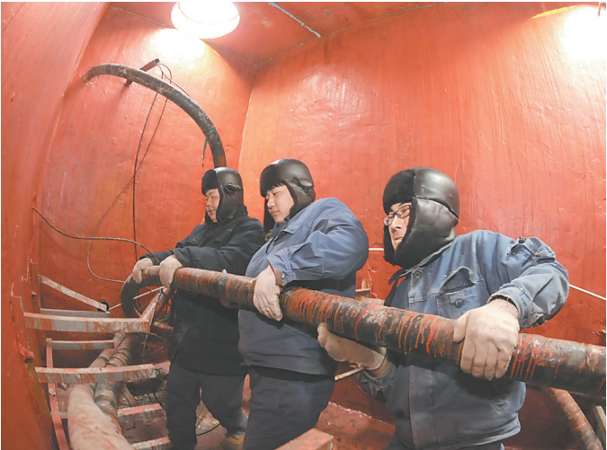
连日来，焦作供电公司组织员工对部分台区进行检修和扩容改造，确保春节期间供电正常。图为该公司工作人员在中铝生活区敷设电缆。 本报记者 杨丽娜 本报通讯员 李晓光 摄
