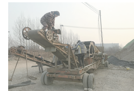
正在对辅助设备进行拆除。 中站区环境监察大队负责人对记者说：“这两家塑料厂主要对回收废弃塑料进行清洗、破碎、造粒，产生的废水废气未经处理直接排放，没有任何防治污染措施且均未办理工商、税务、环保等相关手续，完全符合‘散乱污’企业的特征。因此，我们对其生产设备依法进行了查封、拆除。”在涉事水洗沙场，该负责人说：“这家水洗沙场存在多处环境问题。如石料筛分过程中扬尘污染严重，洗沙过程中产生
