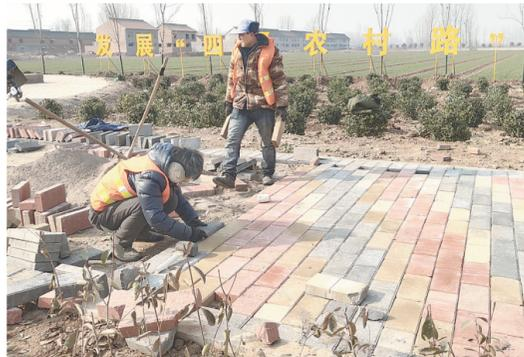
昨日,沁阳市尚(香)依(背)路柏香镇柏香村北段,工人正在进行600米景观步道及广场的施工建设。目前,该镇4米宽的生态步道与行车道的隔离带花池和绿植施工已经结束,3个小型节点游园广场的路基施工基本完工,正在进行硬化作业。本报记者 杨帆 摄
