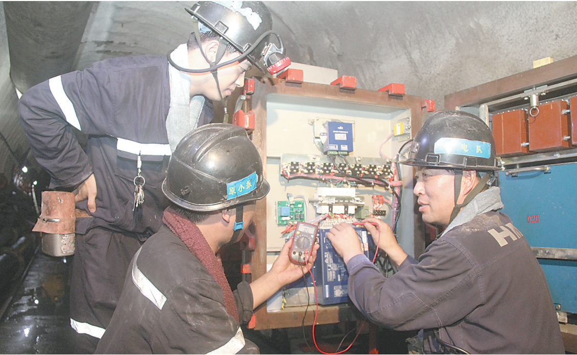
赵固一矿采取“突击式”“走动式”“剖析式”等灵活多样的安全检查方法，持续深入开展安全体检工作，确保矿井安全生产。图为4月18日，该矿机电管理人员在井下变电所排查设备隐患。
