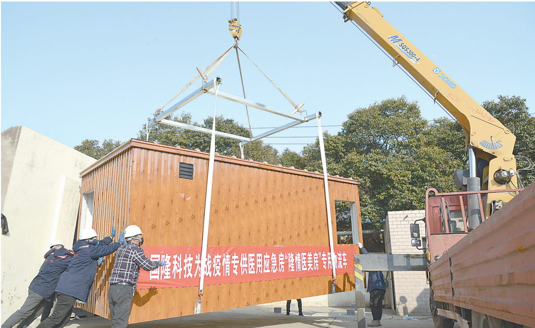
昨日，由国隆科技捐赠的20套应急医用房陆续安装到我市15家医院发热门诊，解决发热病人预检分诊空间不足的问题。图为施工人员在市第三人民医院安装应急医用房。本报记者 翟鹏程 摄
